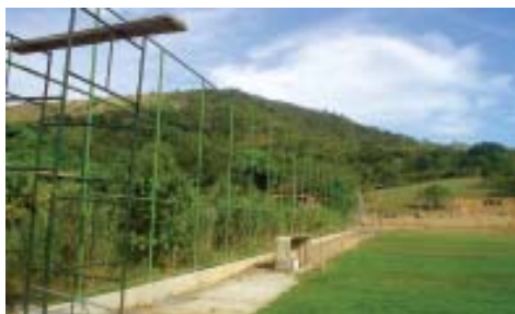
Além da ampliação do campo está sendo construído o alambrado
